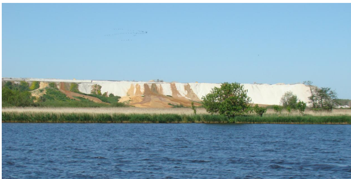
Fotografia III.1.1. Składowisko fosfogipsu ZCh Police SA (źródło: WIOŚ w Szczecinie)
